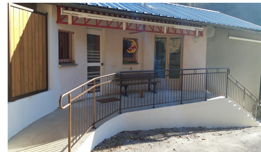
Nouvelle rampe d'accès
